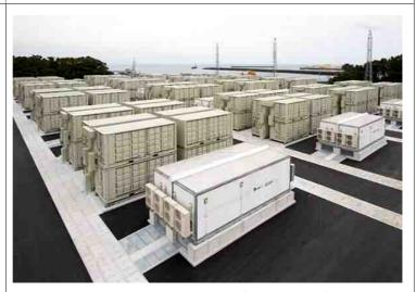
800kW NAS 電池設備(200kW×4 台)
