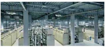
2F 電池盤, 熱交換器, 電池制御盤を設置
